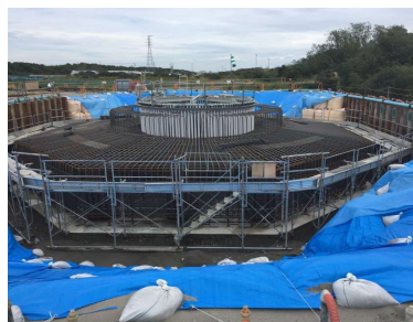
基礎工事（コンクリート打設前）
