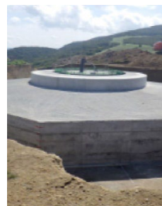
基礎工事（コンクリート打設後）
