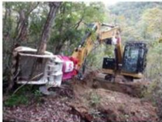
支障木の伐採
